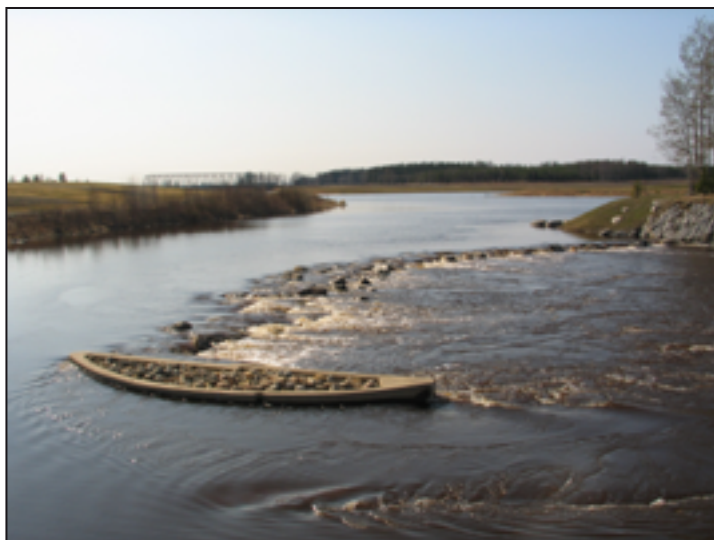
Kalojen nousumahdollisuus on huomioitu Malkakoskeen rakennetussa padossa. Kuva: Pertti Sevola
